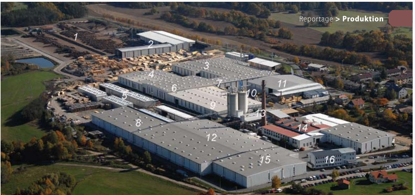
40 ha überdacht: 1 Rundholzplatz, 2 Sägehalle, 3 BSH-Produktion, 4 Sortierhalle, 5 Trockenkammern, 6 BSP-Produktion, 7 Verladehalle, 8 Leisten-/Mittellagenproduktion, 9 KVH-Produktion, 10 Pelletierung, 11 Nagelplattenbinder-Fertigung, 12 Plattenproduktion, 13 Kesselhaus, 14 Fertighausproduktion, 15 Lager, 16 Verwaltung
